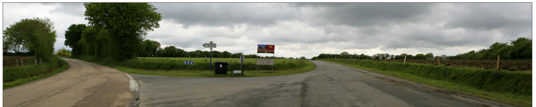
Vue du site avant projet
