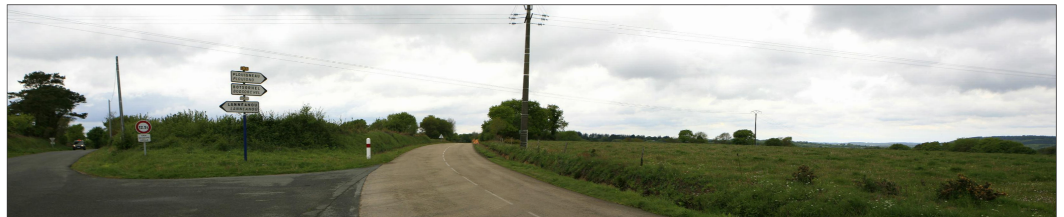
Vue du site avant projet
